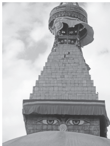
写真4 震災で外壁の損傷したバウダナートウの仏塔
