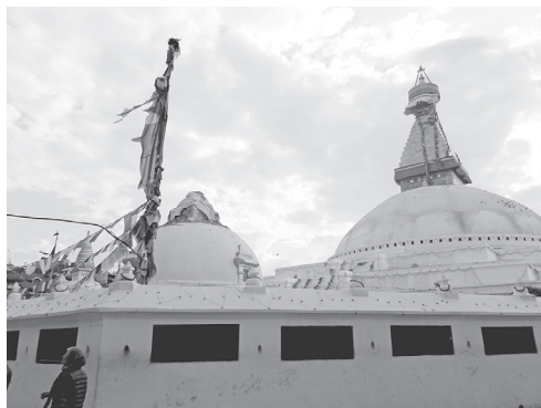
写真3 震災で倒壊したバウダナートウの仏塔
